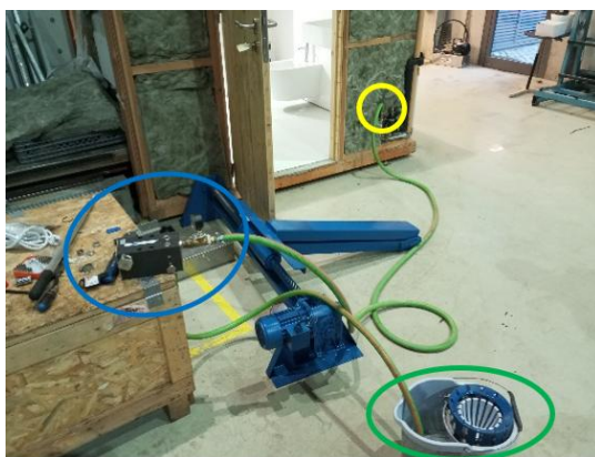
Figura 26: Instalação utilizada no ensaio de estanquidade da rede de abastecimento de água do POD: Bomba hidráulica com manómetro (forma oval azul), alimentada a partir de um reservatório externo (forma oval verde), ligada à rede de abastecimento de água fria através da válvula de seccionamento instalada no extremo de montante da rede (forma oval amarela).
